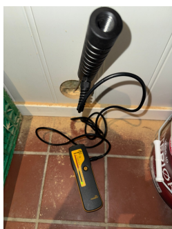
Hulltaking mot vaskerom, fra vindfang
