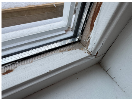
Avflassing innvendig i karm, stue
