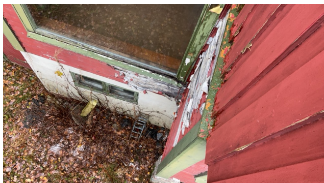
Råteskader
