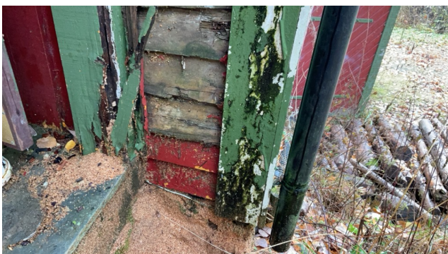
Lekkasje fra renneende, forårsaker oppfukning av yttervegg og videre råte
