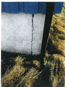
Takvann ført rett ut på bakken.
