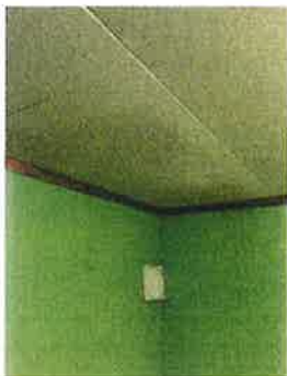
Merker etter at det har vært vann på gulvet i kjeller.
