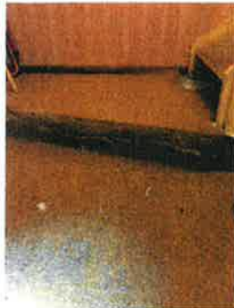
Merker etter at det har vært vann på gulvet i kjeller.
