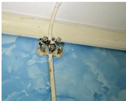
Mangler deksel på koblingsboks.
