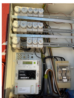
Mangler deksel på koblingsboks.
