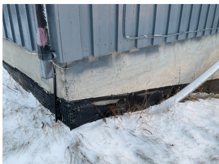
Taknedløp ført ned ved grunnmuren.
