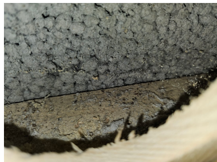
Ikke tegn til misfarging inne i konstruksjonen.
