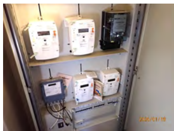
Felles el. skap med strømmålere.
