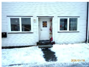
Inntrukket inngangsparti 1. etasje.
