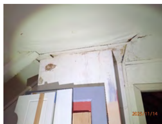
Pipe vestre side loftetasje.
