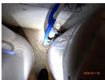
Gulvsluk ved beredere.
