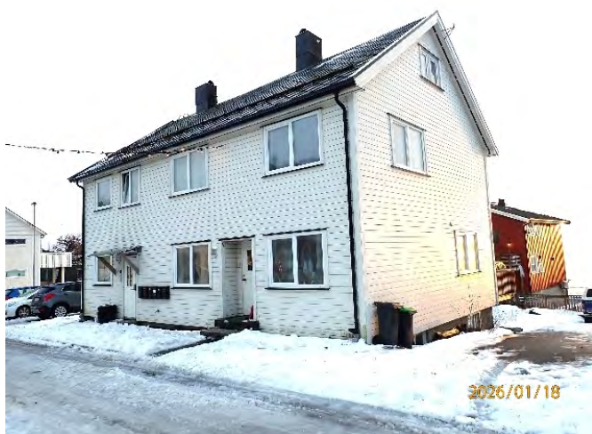
Fasade mot nordvest.
