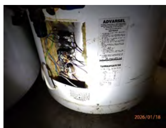
Bereder som mangler beskyttelsesdeksel.
