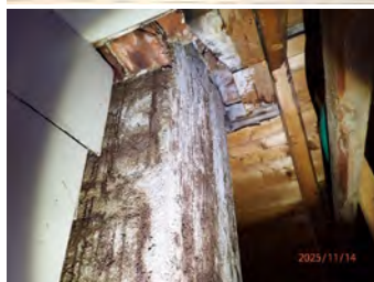
Pipe østre side loftetasje.
