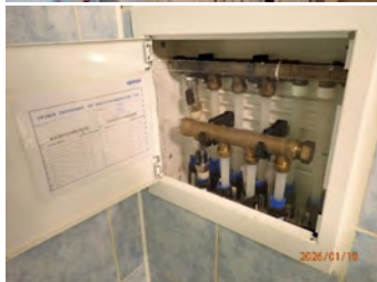
Rør i rørskap på bad/wc i kjeller/underetasje.
