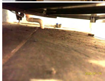
Gulvsluk under dusjkabinett på bad/wc i kjeller/underetasje.
