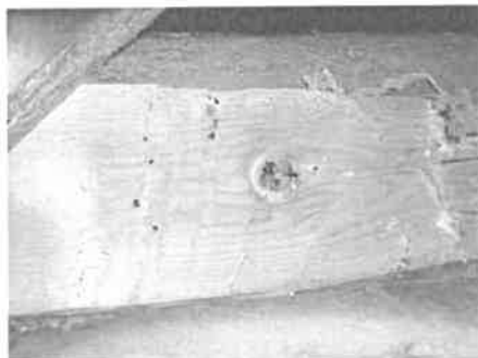
Tegn til borebille i taksperrer.
