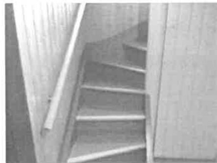
Trapp er smal og bratt. Det er kun ca. 70cm bredde i trappen.
