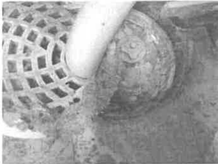
Plastsluk i gulv delvis under badekar.
