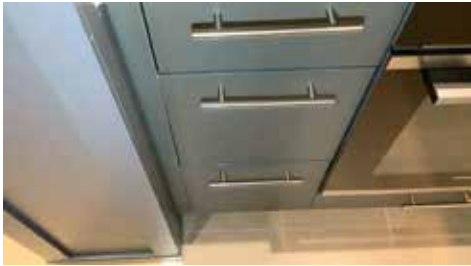
Enkelte skuffefronter/dører i innredningen trenger justering.
