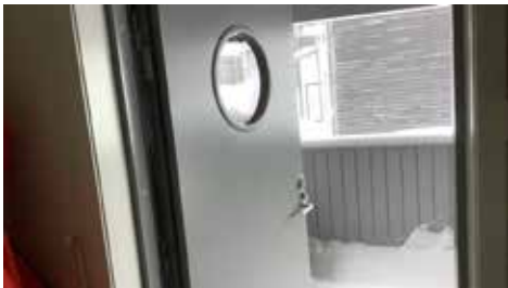
Inngangsdør trenger justering, da den "går på" karm.
