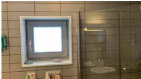
Det er vindu i våtzone
