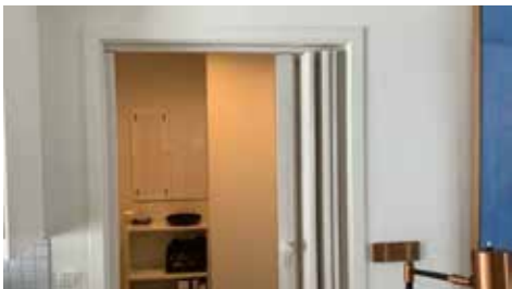
Det er montert en foldedør i åpning mellom stue/kjøkken og gang.
