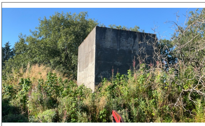
Bunkers på eiendommen
