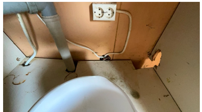
Utildekkede ledninger i vegg
