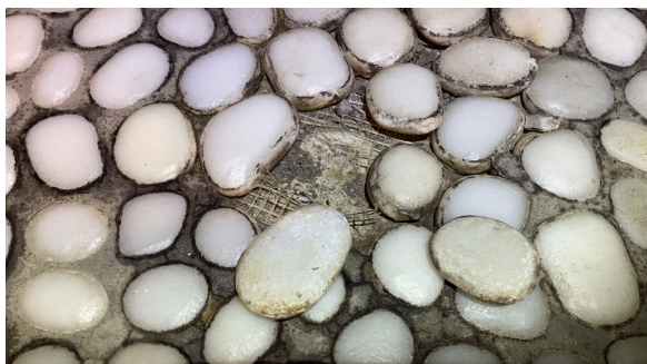
Usikkerhet rundt tetthet på membran.
