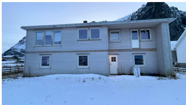
Ny kledning fasade mot nord
