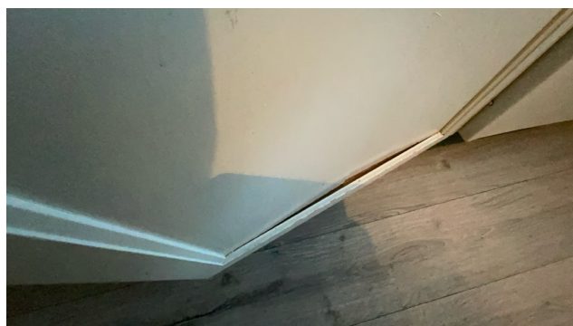
Skade kjøkkenfront
