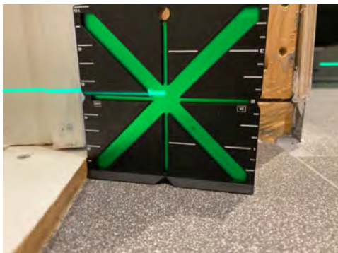
Måling av fallforhold fra dør
