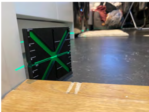
Måling av fall fra dørterskel
