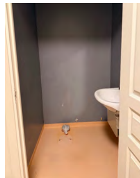
Toalettrom mangler tilluftsventilering, f.eks. spalte/ventil ved dør.
