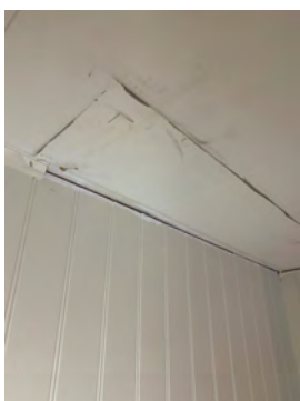
Merker i tak etter tidligere spilevegg.
