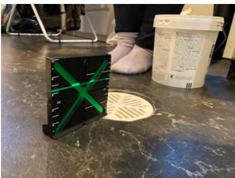
Måling av fall til sluk.
