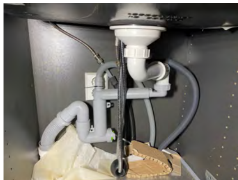
Kontroll av røropplegget.
