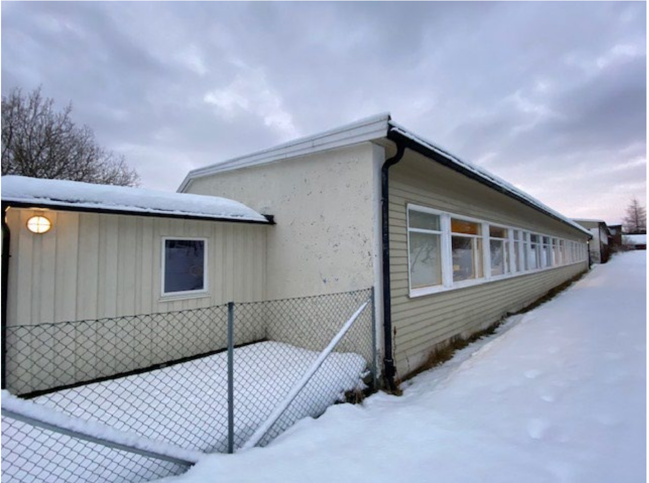
7.7 - Avflassing av maling møt sør.
