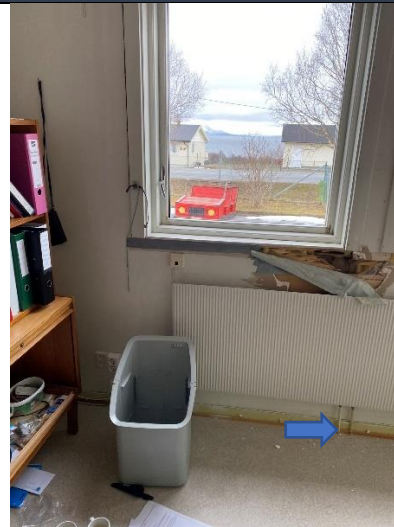
Plassering: Rom Materialtype: Rørgjennomføring fra radiator. Finnes i hele bygningsmassen
