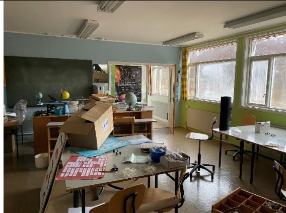
Plassering: Naturfag-heimkunnskap, 2.etg. eldre undervisningsfløy EE-type: Lysarmatur og lysstoffrør
