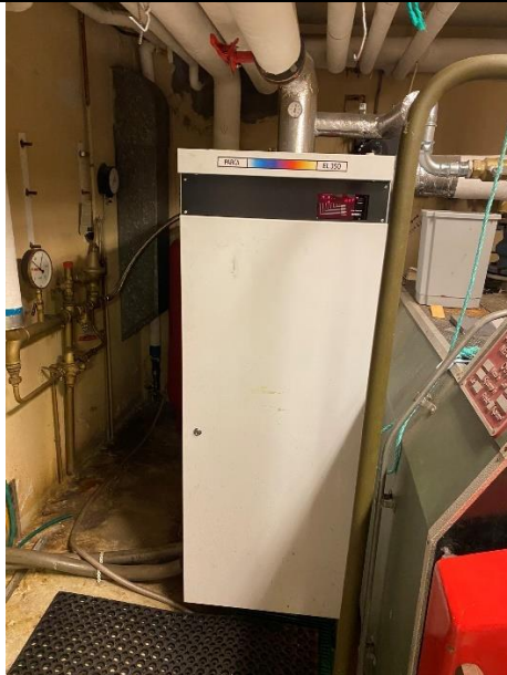
Plassering: Fyrrom EE-type: Elkjel
