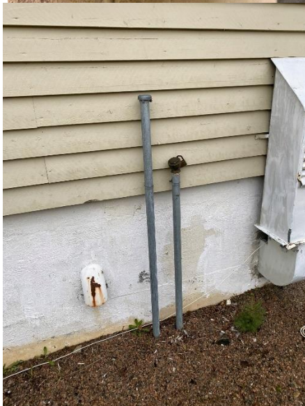
Plassering: Nedgravd på oversiden av fyrrom Materialtype: Oljetank Verdi/antall m 2 : 1 stk, oppgitt til 4000L.
