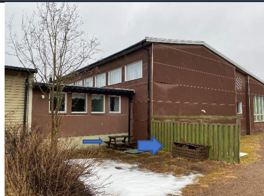
Plassering: Utendørs Materialtype: Trykkimpregnert trevirke med ukjent produksjonsår.
