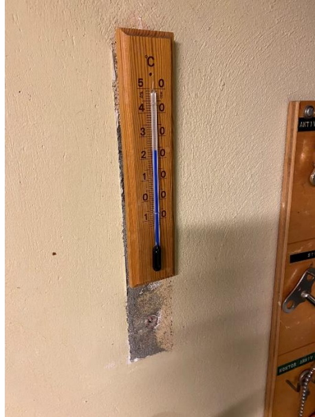
Plassering: Fyr- og vent.rom Materialtype: Termometer
