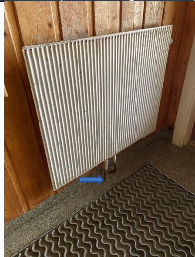
Plassering: vf/korridor Materialtype: Rørgjennomføring fra radiator. Finnes i hele bygningsmassen
