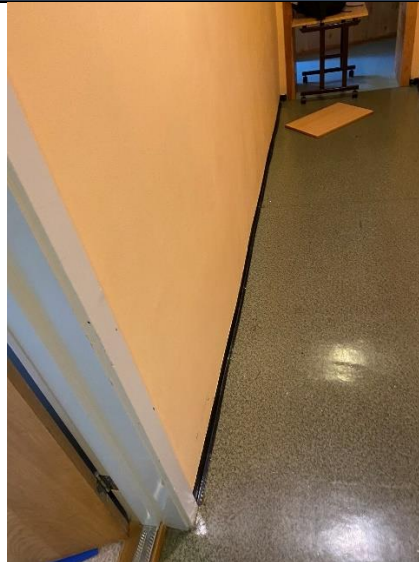
Plassering: Gang, 2. etg. overgangsareal mellom gymsalfløy og eldre undervisningsfløy Materialtype: Vaskelist
