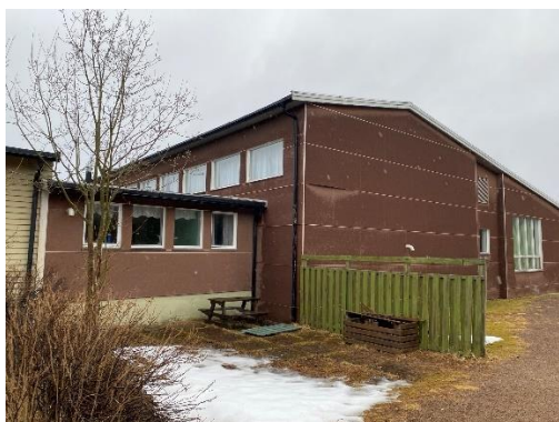
Oversiktsbilde fra baksiden av gymsalfløya
