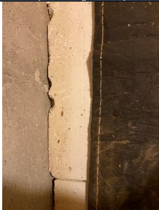
Plassering: Ventilasjonsrom på loft over byggetrinn 3 Materialtype: Harde isolasjonsplater
