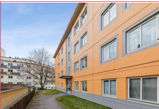
Fasade - Amtmann Meinichs gate 7
