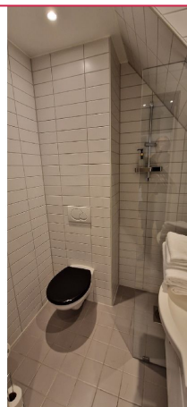
Opplegg til oppvaskmaskin på bad.
