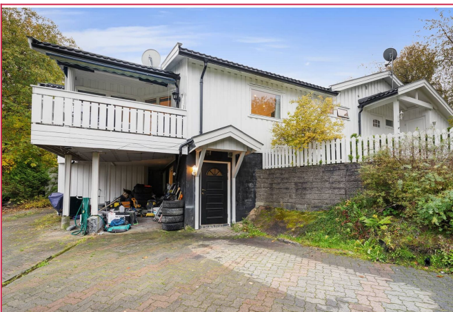
Leiligheten disponerer en carport og en biloppstillingsplass i forkant av denne
