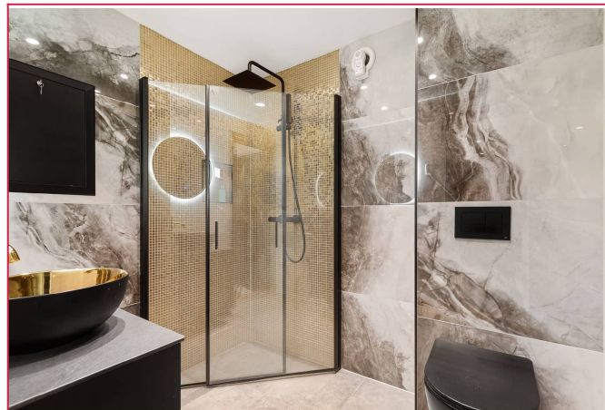
Badet har i tillegg vegghegt WC og waterguard/lekkasjestopper installert
