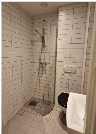
Pent flislagt bad med varmekabler i gulv.
