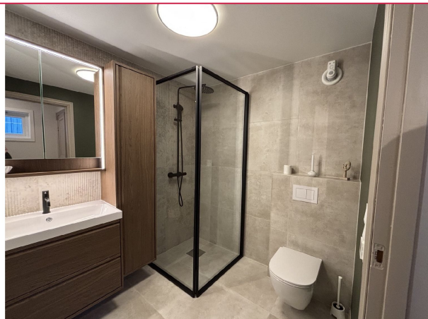
Nytt baderom 2025 med vaskemaskin og tørketrommel. Varmekabler i gulv.
