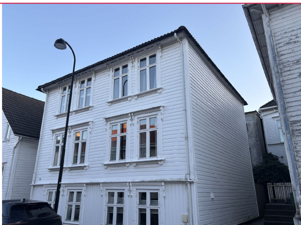
Fasade. Leiligheten ligger i høy 1. etasje med lite innsyn.
