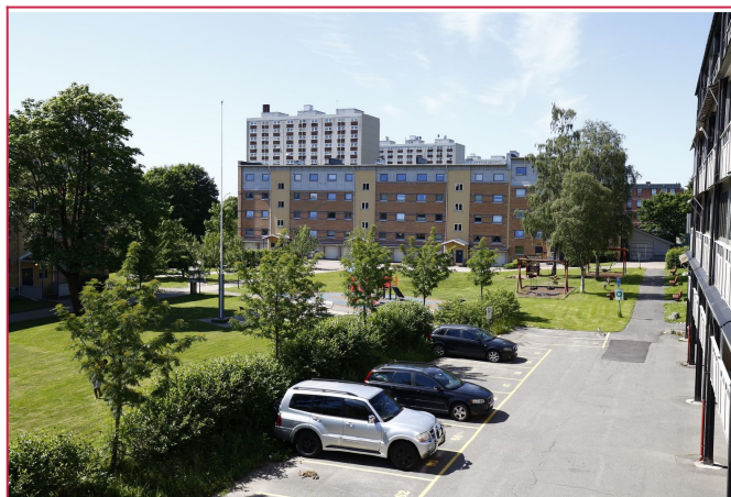
Leiligheten har egen biloppstillingsplass
