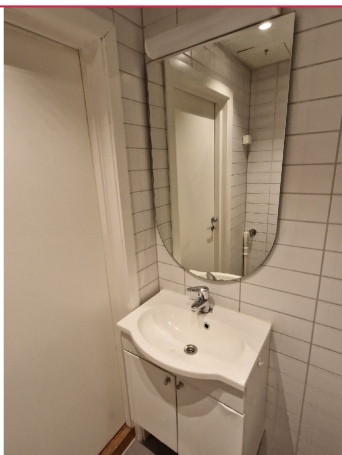
Opplegg til vaskemaskin på bad.
