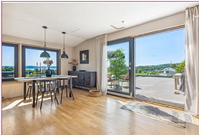
Utgang til terrasse fra stue. Himling og manglende dør/vinduskarmer blir utbedret før innflytting.
