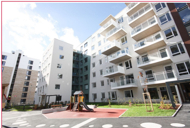
Fasade - Pent opparbeidet uteareal
