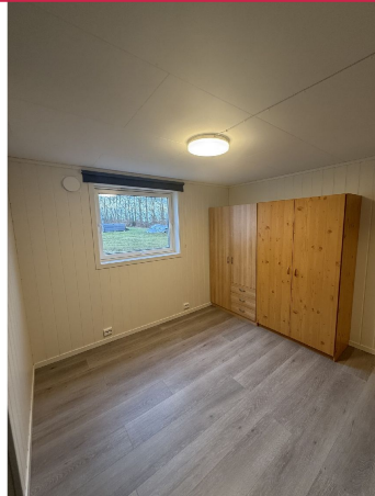
Rom 2 i kjeller - ikke godkjent til varig opphold
