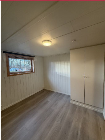
Rom 1 i kjeller - ikke godkjent til varig opphold
