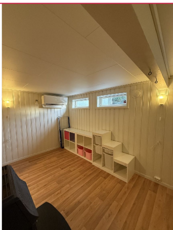
Kjellerstue med varmepumpe - ikke rom til varig opphold
