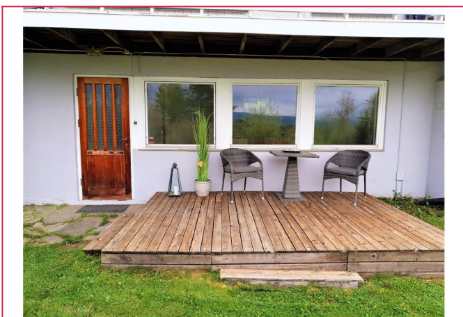
Stor terrasse med plass til utemøblement. Det er nå bygget en utebod på venstre side.
