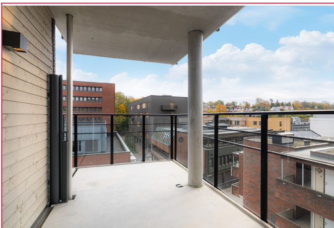
Balkong - Sør side.
