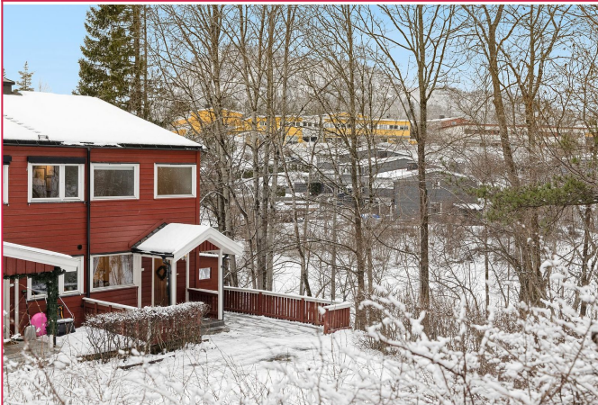
Oversiktsbilde av fasaden
