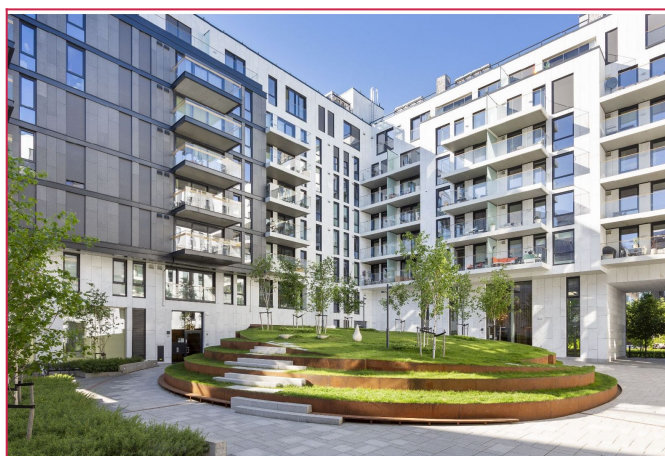
Fasade fra bakgård
