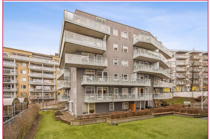
Fasade- leiligheten ligger på hjørne i 3 etg.
