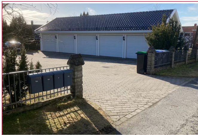
Parkering i garasje
