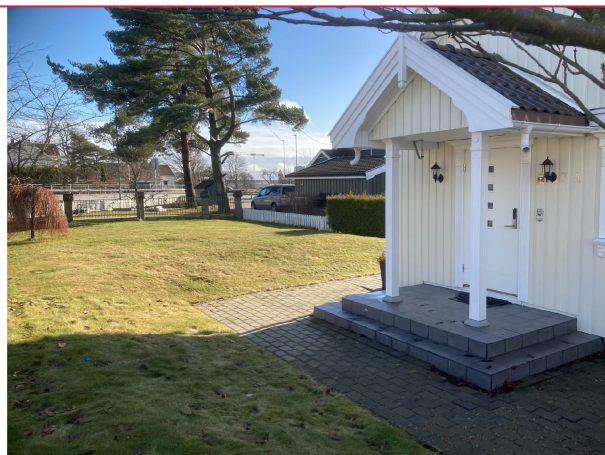
Egen entré på siden av bygget.
