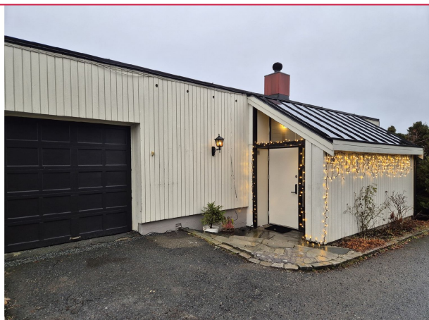
Eiendommen disponerer garasje med el-billader.
