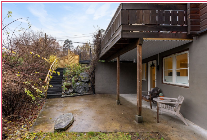
Leiligheten har egen, privat adkomst rett fra veien. Uteplass under tak.
