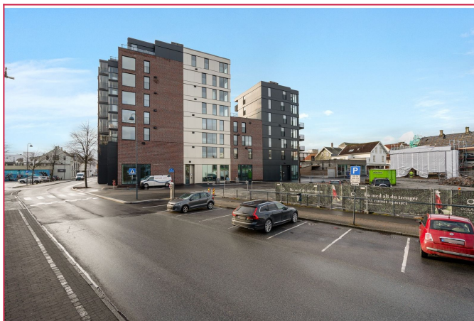
Erling Skjalgsonsgate 2c ligger like ved Byterminalen
