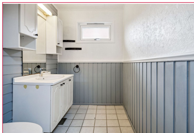
2.etasje: Delvis flislagt wc med servantskap og gulvvarme.
