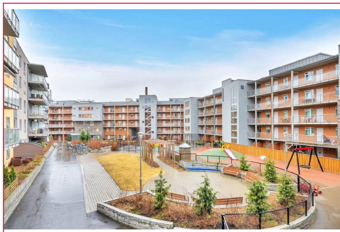
Bakgård / fellesareal - Konfektfabrikken
