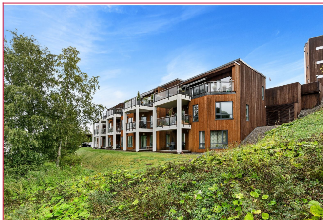
Fasade - Boligen ligger omringet av nydelige grøntarealer
