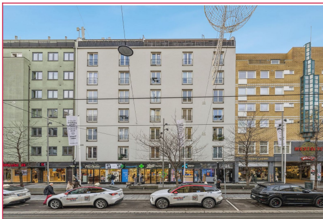
Fasade ut mot Bogstadveien | Leiligheten vender mot andre siden
