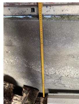
Ved høyde på over 0,5 meter over bakkenivå, skal det være montert rekkverk for å kunne forhindre fallulykker.
