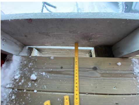
Åpning mellom rekkverk og dekket ca. 6 cm.
