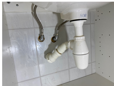
Manglende tetting i vegg rundt rørgjennomføringer.
