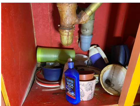
Kontroll av røropplegget.
