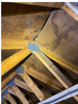
Manglende tetting rundt rørgjennomføringer.
