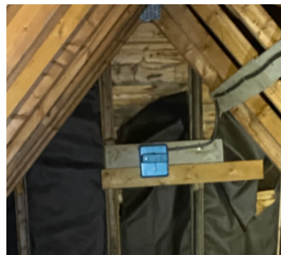
Tegn til råteskader på kledningsbord mot gavlvegg
