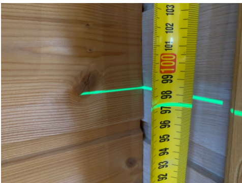
Måling av høydeforskjell, stue.
