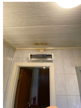
Avstand mellom taket og stråleovn bør økes.
