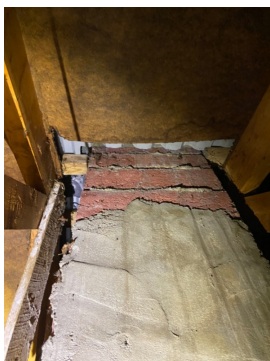
Manglende tetting rundt rørgjennomføringer.
