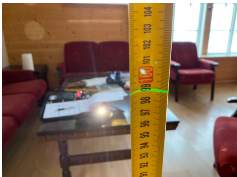
Måling av høydeforskjell, stue.
