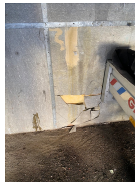
Skader i eternittplate i garasjen.
