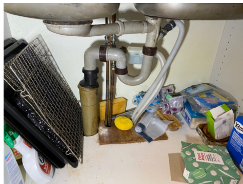
Kontroll av røropplegget.
