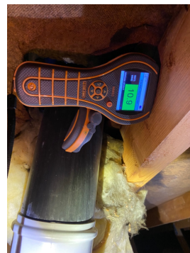
Fuktmåling i takkonstruksjon viste ingen forhøyede fuktverdier.
