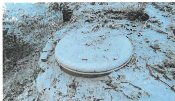
Septiktank sør på eiendommen
