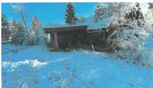
Carport mot nord
