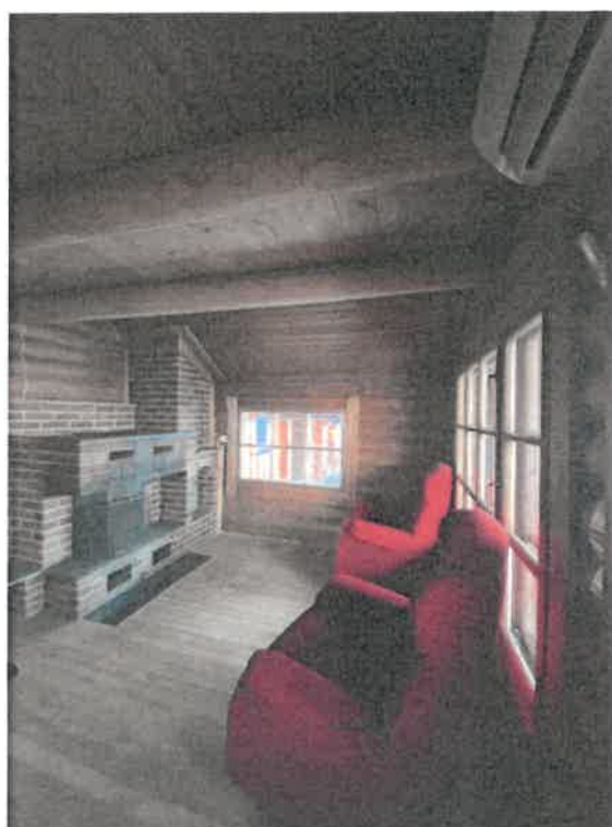
Innvendige vegger med synlig tømmer og panel, gulv av skifer og heltre, og himlinger med panel over synlige takåser.
