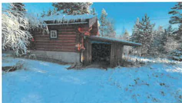
Carport/redskapsskjul mot sør.
