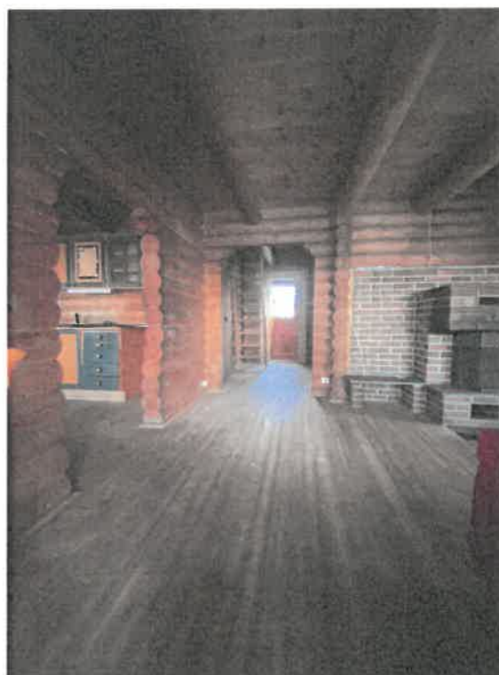
Innvendige vegger med synlig tømmer og panel, gulv av skifer og heltre, og himlinger med panel over synlige takåser.
