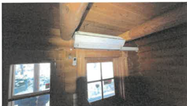
Luft-til- luft varmepumpe i stue
