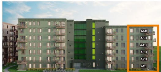
Bygg A, fasade mot nord
