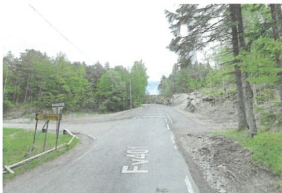
Bilde 1 Kryss mellom riksvei 401 og fylkesvei 3650
