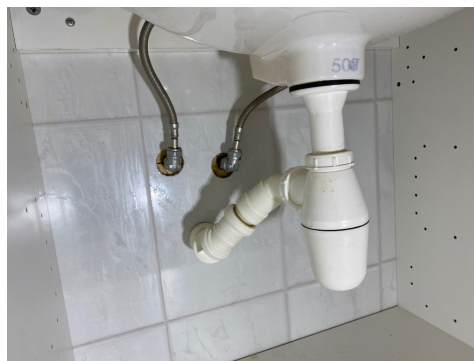
Manglende tetting i vegg rundt rørgjennomføringer.
