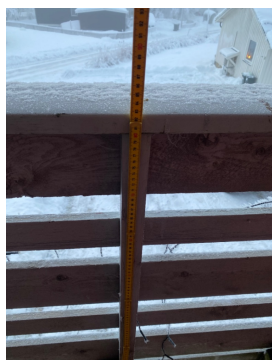
Åpning mellom rekkverk og dekket ca. 6 cm.
