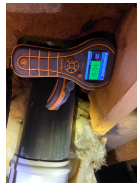
Fuktmåling i takkonstruksjon viste ingen forhøyede fuktverdier.
