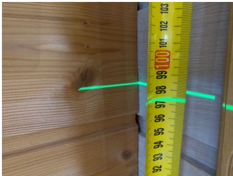
Måling av høydeforskjell, stue.
