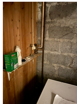
Viser noe saltutslag på Lecavegg i kjeller
