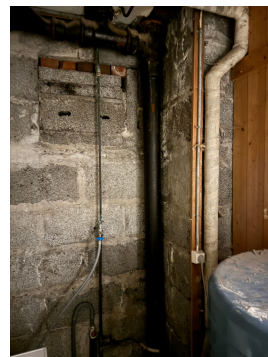
Viser noe saltutslag på Lecavegg i kjeller
