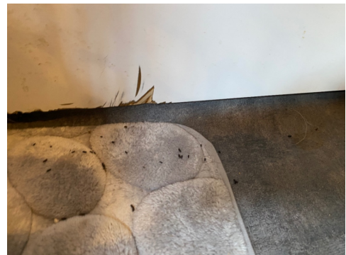
Skade i nedkant av plater, manglende alulist
