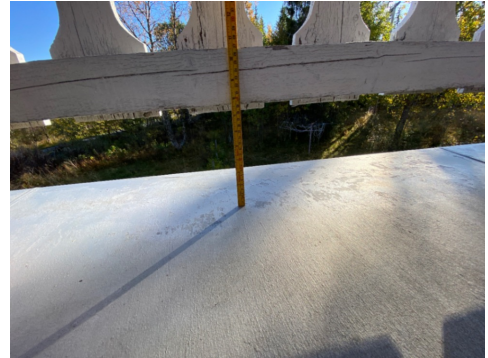
Åpning under rekkverk.
