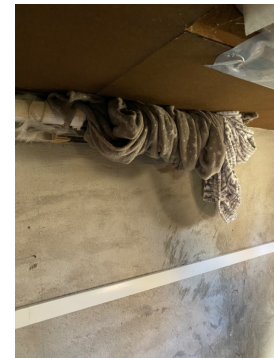
Isolering rundt vannrør, kjeller.
