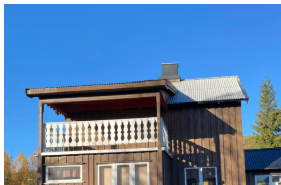
Tak sett fra øst.
