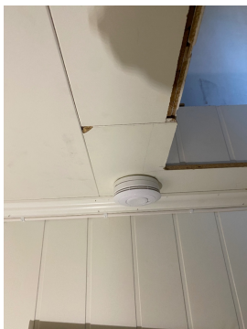
Røykvarsler i loftsetasjen mangler.
