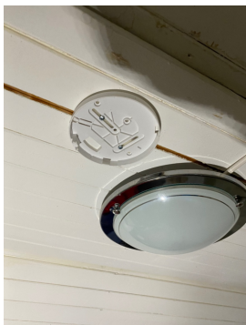
Røykvarsler i loftsetasjen mangler.
