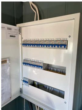
Sikringsskap med automatsikringer, plassert i gangen.
