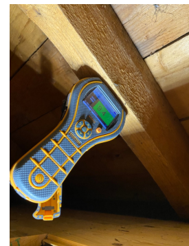
Fuktmåling, ingen forhøyde verdier
