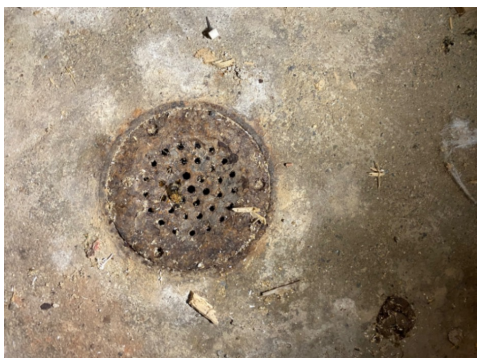
Soilsluk i kjeller.
