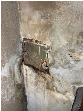
Rust i sotluke, saltutslag, løs murpuss i kjeller.
