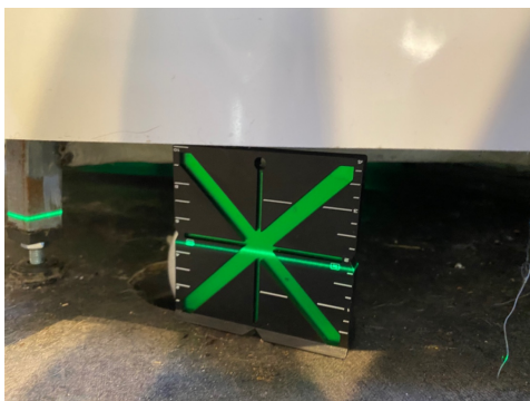
Måling av fall til sluk.
