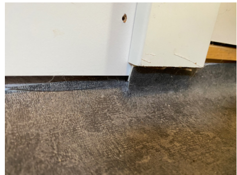
Skade i nedkant av plater, manglende alulist
