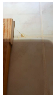
Brist skader i flis samt en del bom( Hullrom under flis registreres.)
