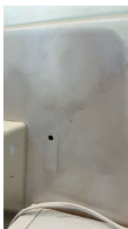
Manglende tetthet og ingen tegn til membran rundt sluk og rørføringer.
