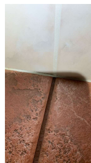
Brist skader i flis samt en del bom( Hullrom under flis registreres.)
