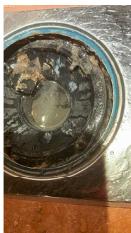
Manglende tetthet og ingen tegn til membran rundt sluk og rørføringer.
