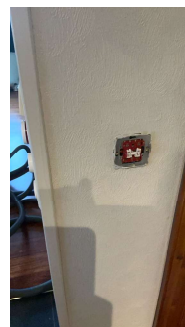
Åpne stikkontakter/ brytere stedvis.
