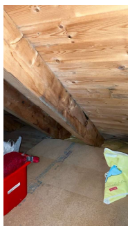
Forhøyede fuktverdier måles lang raft
