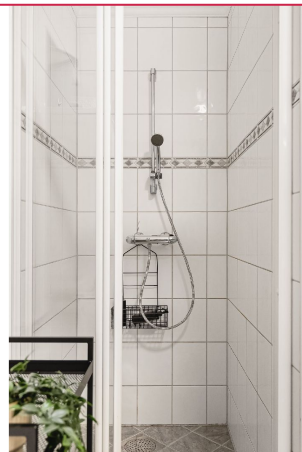
Dusjsone på bad
