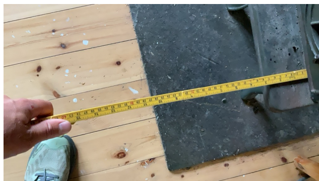
Skifer på gulv under vedovn er for kort ihenhold til krav om avstand
