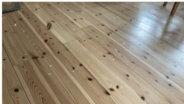
Malingsrester på overflater
