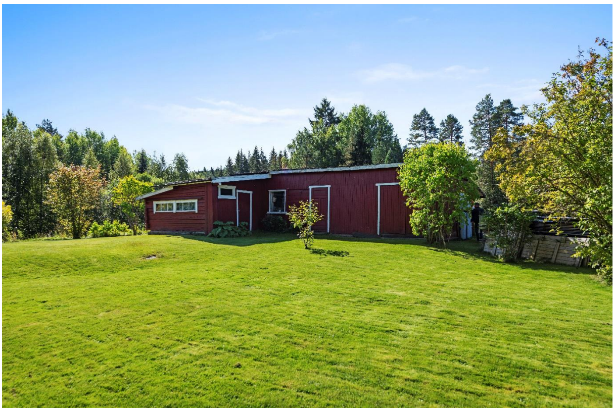
Det i front av «stallen» tilhører eiendommen. Bygningen er delt vertikalt i front av hvite dører som skimtes på høyre side.
