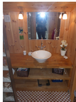
Viser trepanel i våtsone servant.
