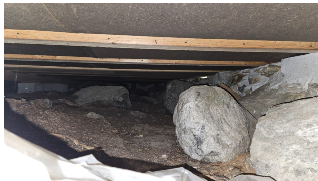
Viser krypkjeller sett fra ventilutsparing mot sør.
