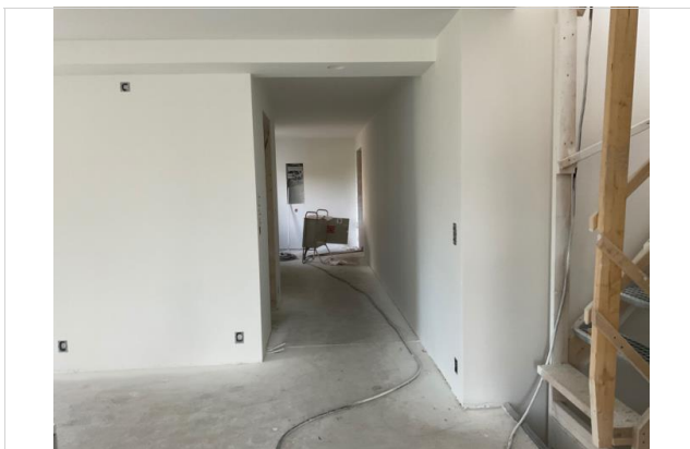
Bilder tatt på befaring.
