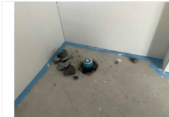
Bilder tatt på befaring.
