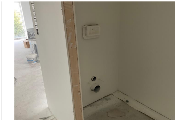
Bilder tatt på befaring.
