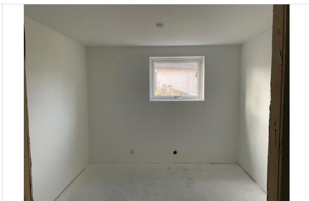
Bilder tatt på befaring.
