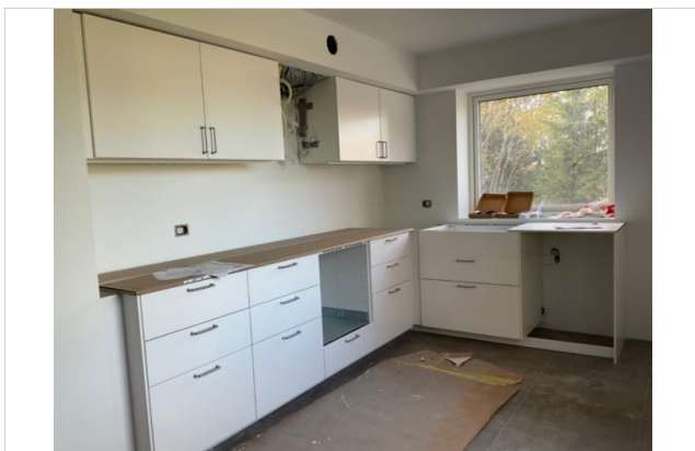
Bilder tatt på befaring.
