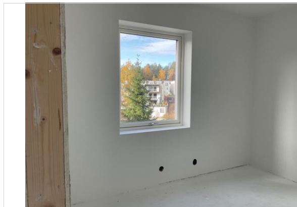
Bilder tatt på befaring.
