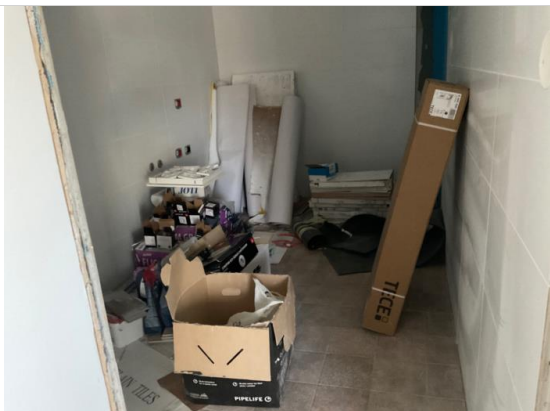
Bilder tatt på befaring.
