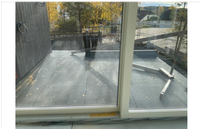
Bilder tatt på befaring.
