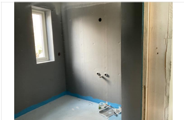
Bilder tatt på befaring.
