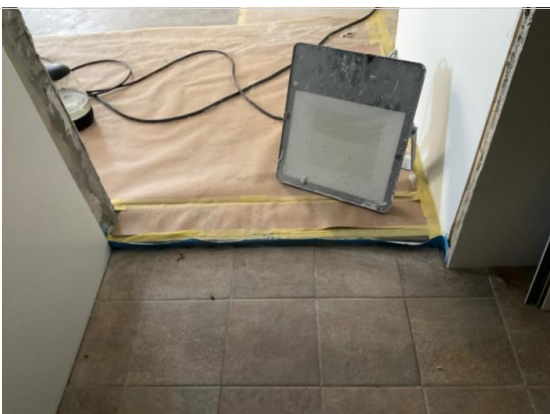
Bilder tatt på befaring.
