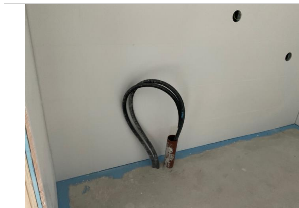
Bilder tatt på befaring.
