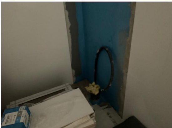
Bilder tatt på befaring.
