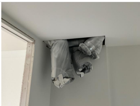
Bilder tatt på befaring. Ventilasjonsskanaler hvor aggregat skal plasseres.
