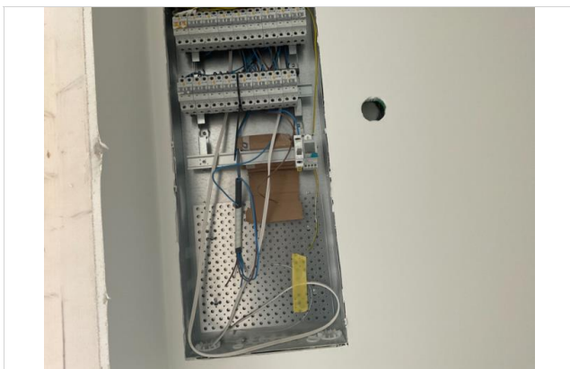
Bilder tatt på befaring.
