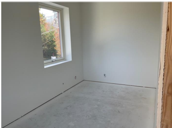
Bilder tatt på befaring.
