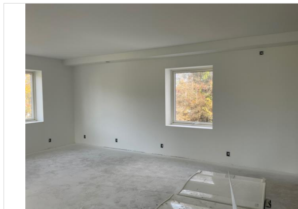
Bilder tatt på befaring.
