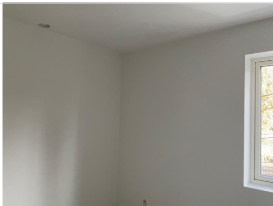
Bilder tatt på befaring.
