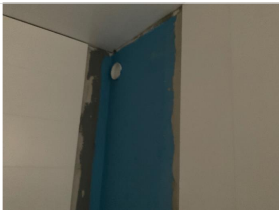
Bilder tatt på befaring.
