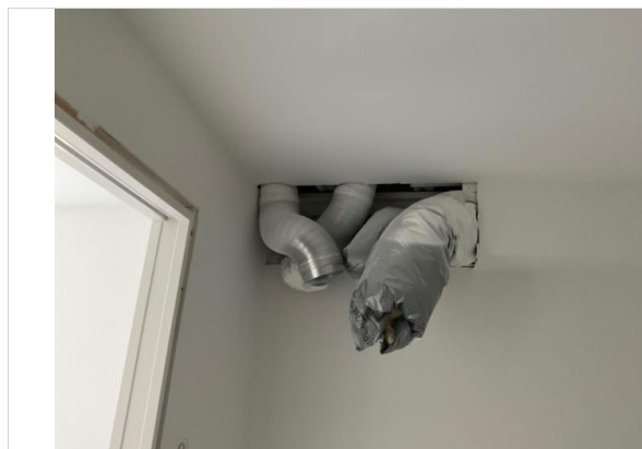
Bilder tatt på befaring.
