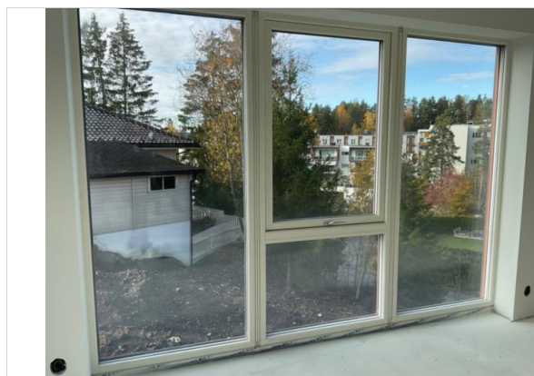
Bilder tatt på befaring.
