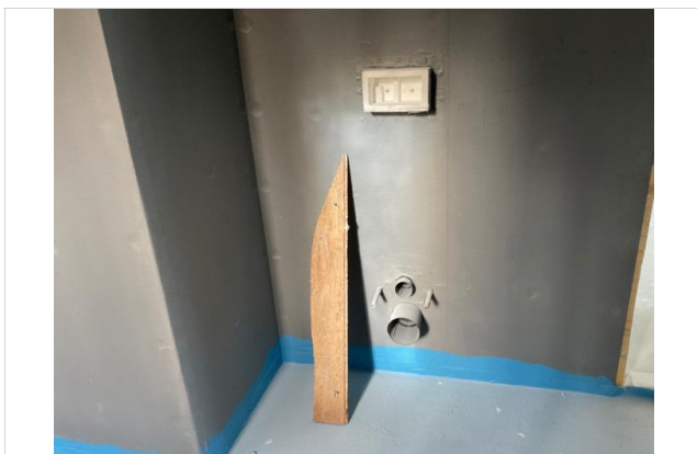
Bilder tatt på befaring.
