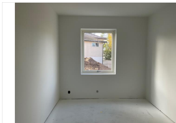
Bilder tatt på befaring.
