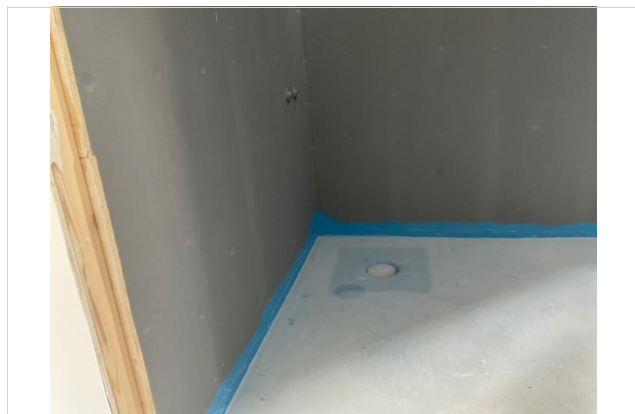
Bilder tatt på befaring.
