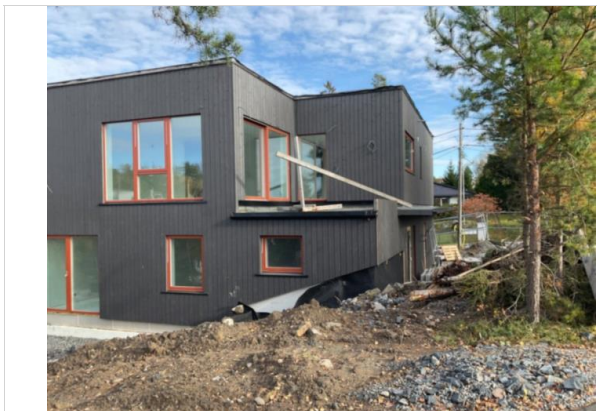
Bilder tatt på befaring.
