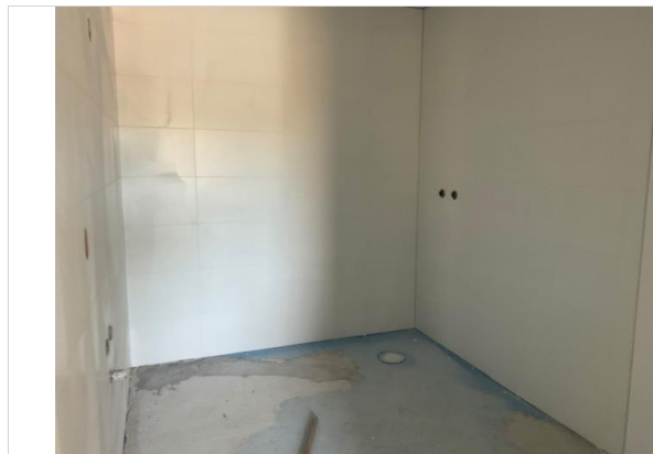
Bilder tatt på befaring.
