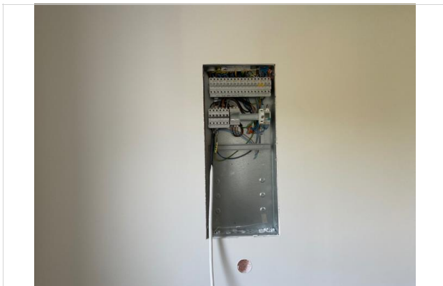
Bilder tatt på befaring.
