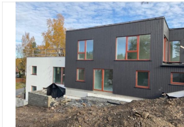
Bilder tatt på befaring.
