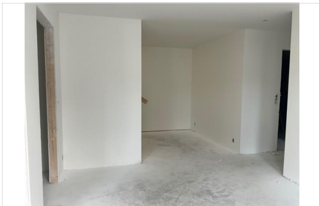
Bilder tatt på befaring.
