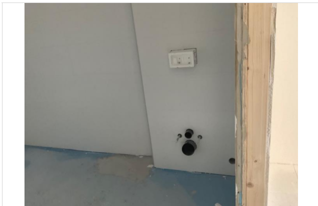
Bilder tatt på befaring.
