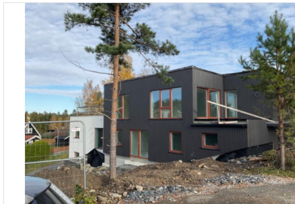
Bilder tatt på befaring.
