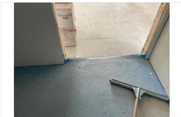
Bilder tatt på befaring.
